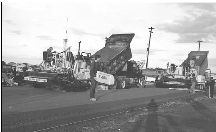
شکل ۴-۴- بتن غلتکی در اف.تی.بنینگ
