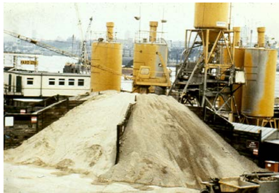
شکل ۳-۴ استفاده از دیوار جداکننده در نگهداری سنگدانه‌ها
