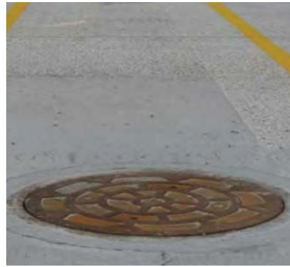
شکل ۳-۲ مغزه‌گیری و آب‌بندی در اطراف یک دریچه آدم‌رو دایره‌ای
