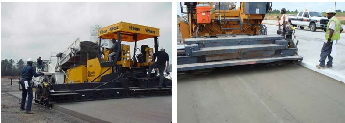
شکل ۲-۴ نمایی از فینشرهای مخصوص رویه بتن غلتکی
